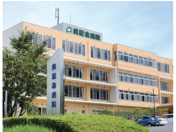
塗り替え後の外観。オレンジに近いクリーム色を基調に、階の境目と非常階段の部分にはアクセントとして白を入れた。
