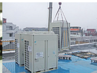
空調室外機搬入
