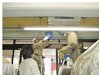
空調システム入れ替え作業
