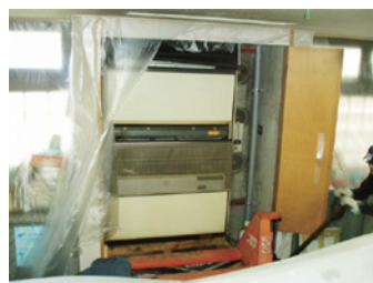
旧空調室内機撤去
