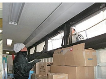
窓ガラス二重化作業
