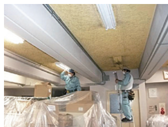
照明入れ替え作業
