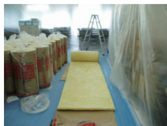
3階天井裏に敷設した断熱材
