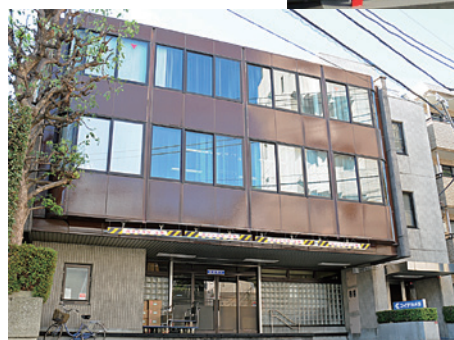
今回省エネ改修を実施した本社社屋（東京都杉並区）
